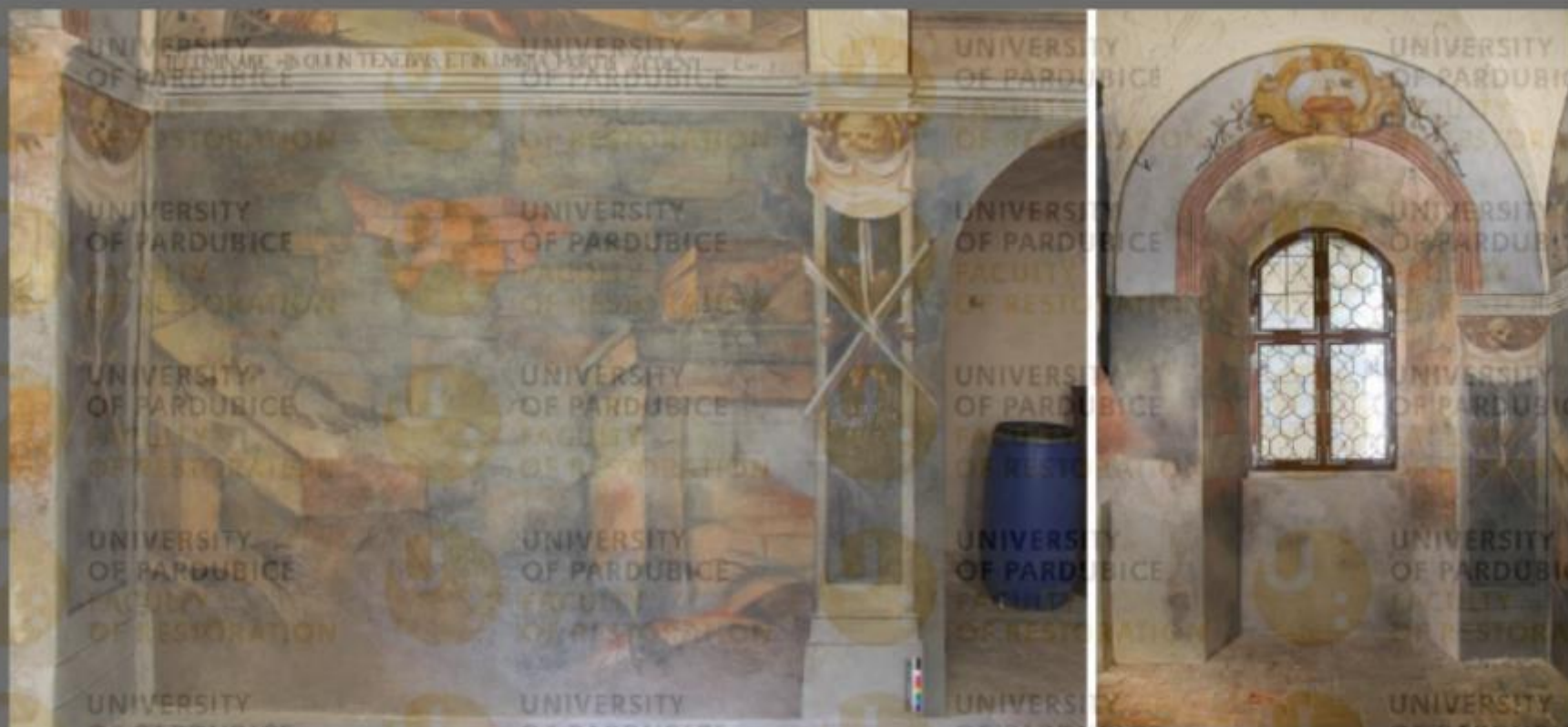
Stav po restaurování
